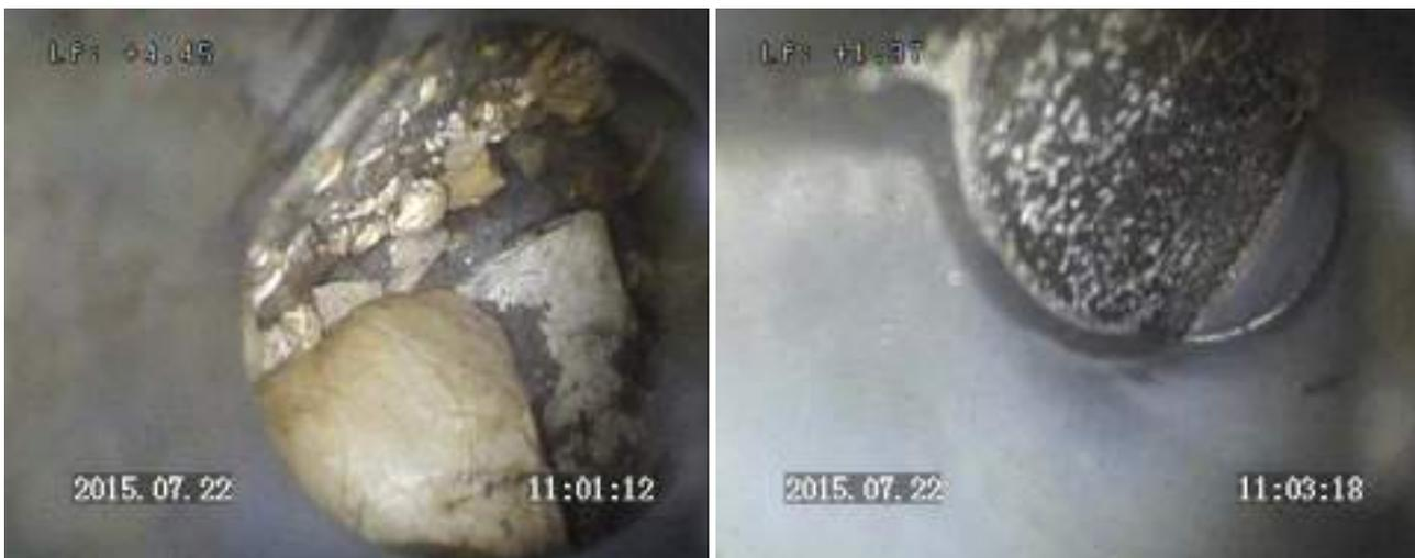
**Figure 8 : Canalisation de droite : partie amont cassée et aval obstruée**
