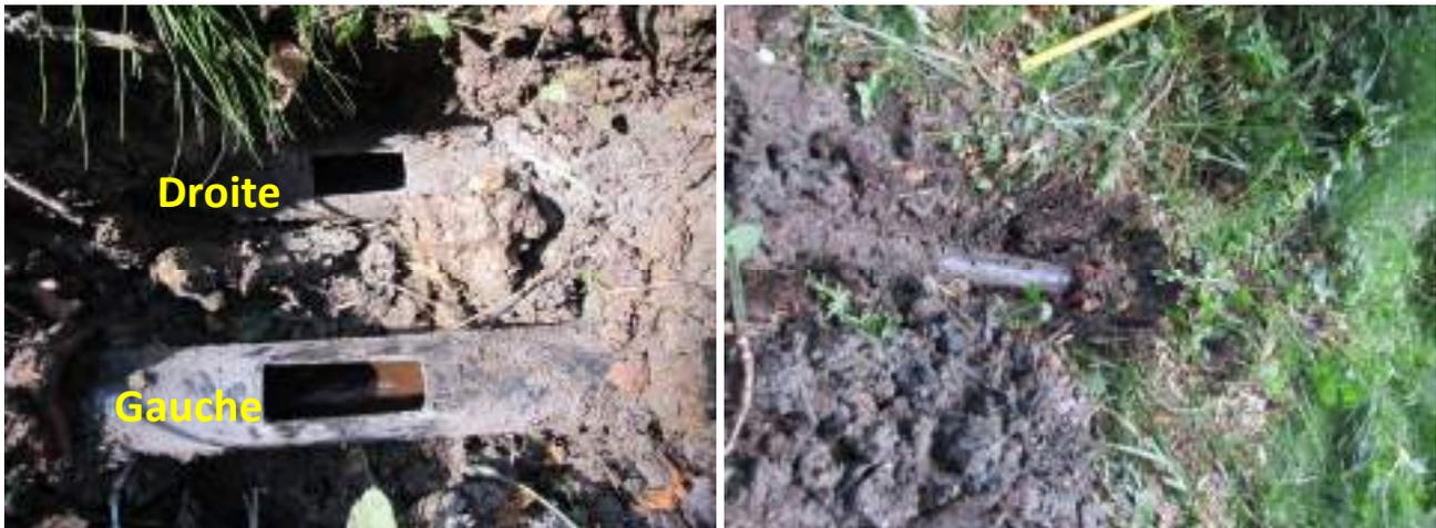
Figure 5 : Ouvertures réalisées dans les canalisations amont
