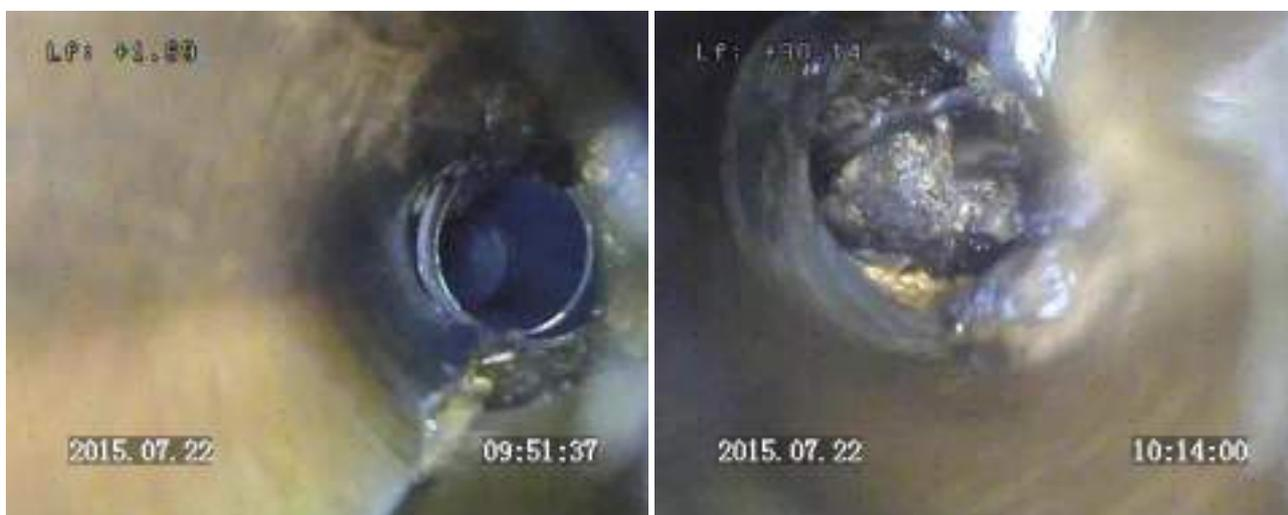
**Figure 6 : Décalage du tubage et cassures au niveau de 2 anciennes ouvertures**
