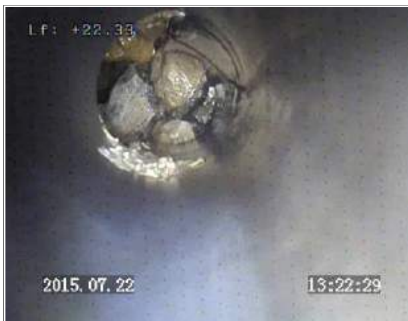
Extrémité de la canalisation centrale longue de 22,5 m : arrêt sur massif drainant
